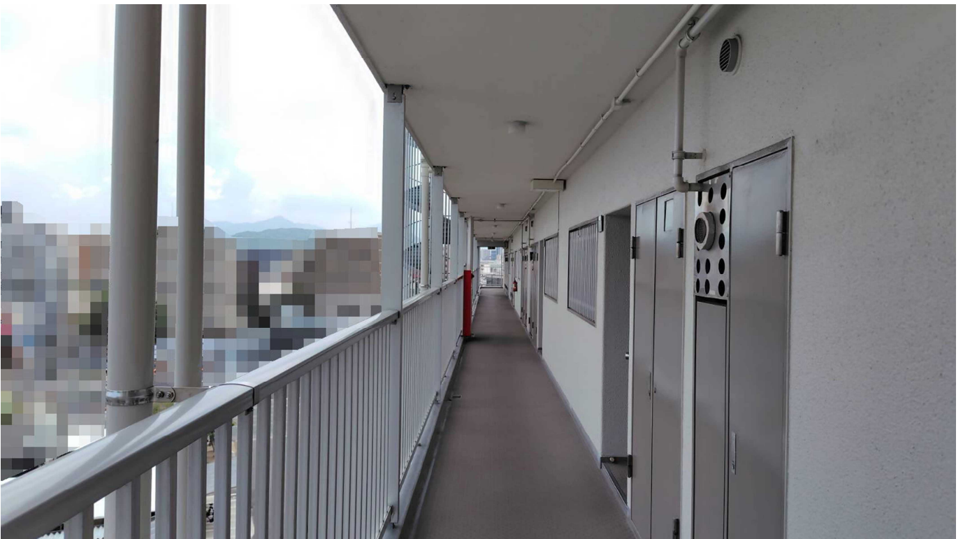
共用部（5階部分 公売物件前の廊下）
