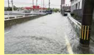
▲大雨で冠水した大土居交差点付近 (令和5年7月)
