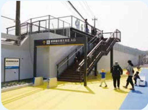
▲完成した新幹線の見える丘の展望施設
