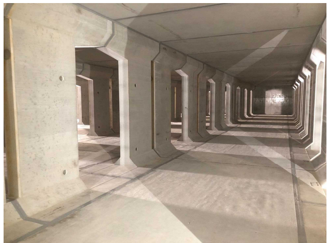
小倉第3雨水貯留施設内部
