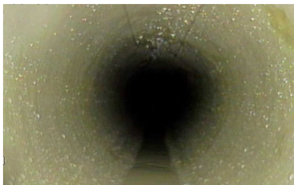
改築した汚水管路
