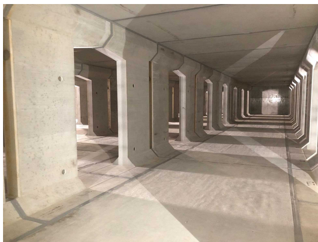
小倉第3雨水貯留施設内部
