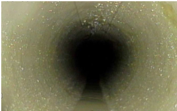
改築した汚水管路
