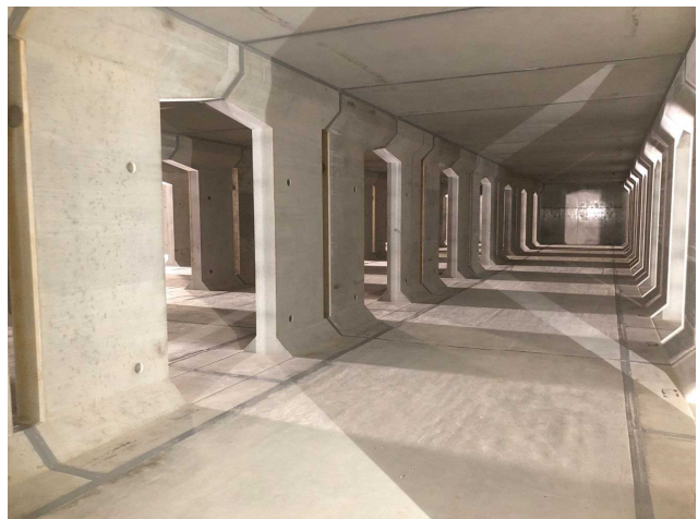
小倉第3雨水貯留施設内部
