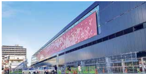
▲整備が進む西鉄春日原駅周辺(令和7年4月)
