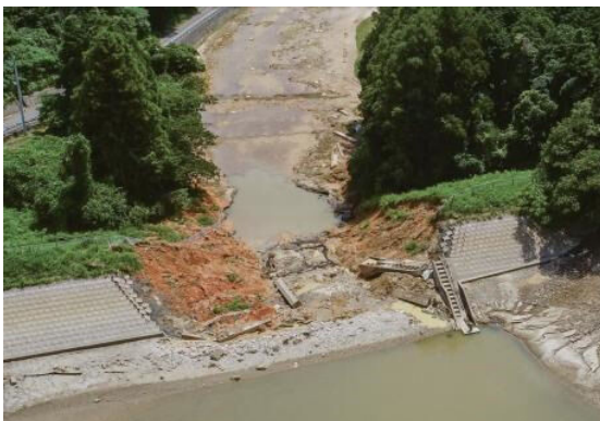
図 決壊した中島池の堰堤
