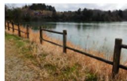
安全柵の破損状況
