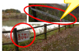
応急対策の状況
