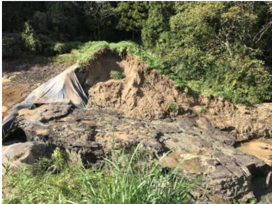
図 決壊した逆川上ため池の堤体
