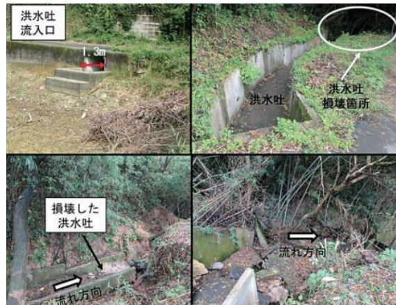
図 洪水吐の損壊状況
