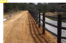
全面更新整備の状況
