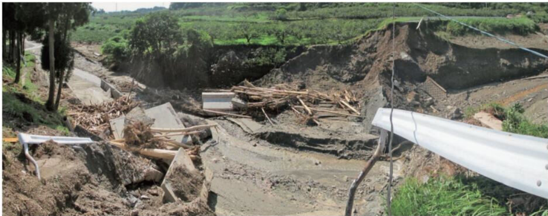
図 平成 29 年 7 月豪雨によるため池の決壊（福岡県朝倉市山の神ため池）
