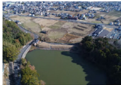
土地改良区が管理する一部のため池は、堤体が地域住民の利用する道路になっており、人通りが多いところもある。
