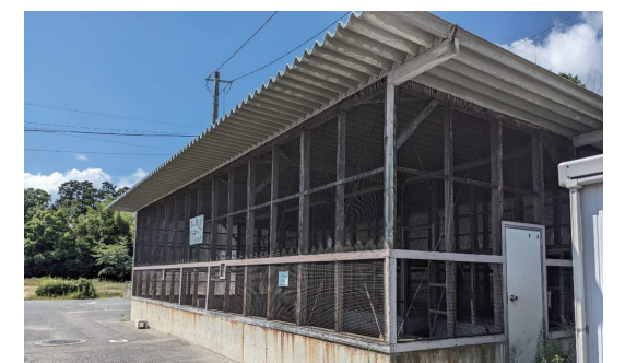
大谷小学校 動物小屋（解体予定）
