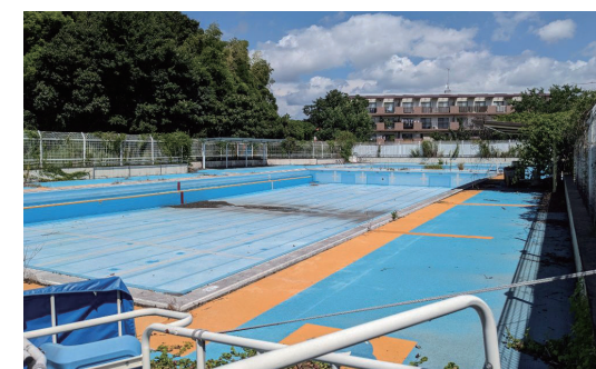
大谷小学校 プール（解体予定）
