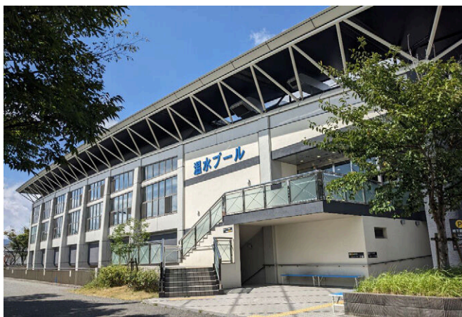
総合スポーツセンター温水プール
