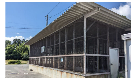
大谷小学校 動物小屋(解体予定)
