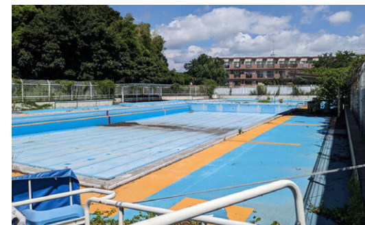
大谷小学校 プール(解体予定)
