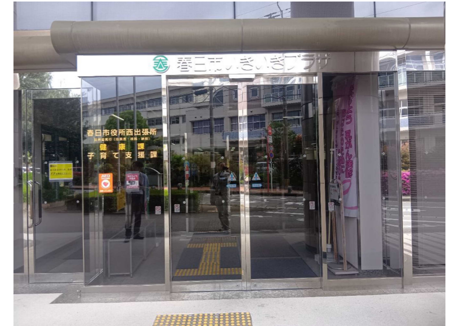
<東側建物入口（自動扉）写真及び有効開口>
