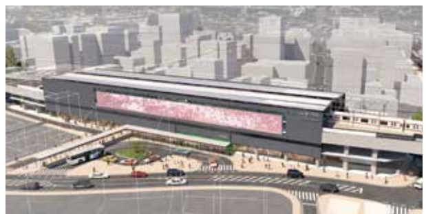
▲完成間近の西鉄春日原駅の新駅舎のイメージ
