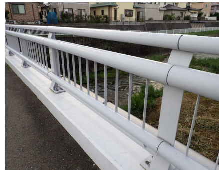
写真-5.8 修繕後（取り換え）
