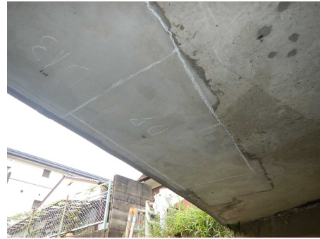
写真-5.2 修繕後（断面修復）
