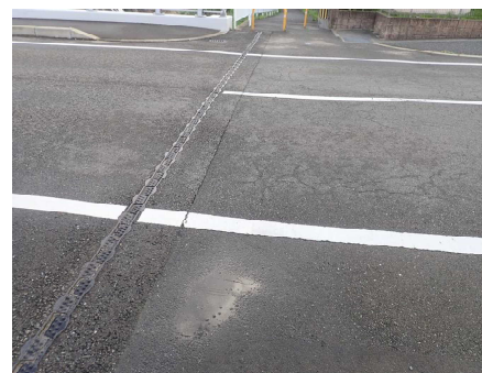
写真-5.6 修繕後（取り換え）
