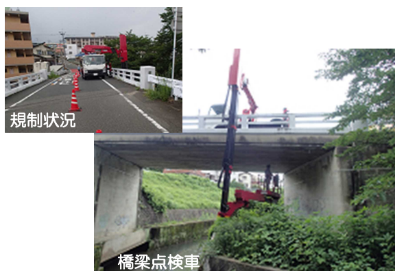
写真-6.1 令和2年_点検作業状況（橋梁点検車）
