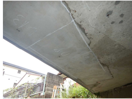
写真-5.2 修繕後（断面修復）
