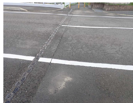
写真-5.6 修繕後（取り換え）
