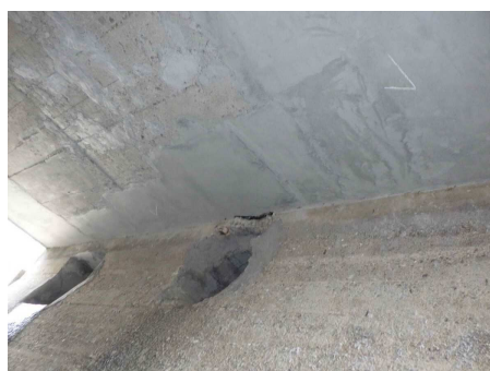
写真-5.2 修繕後（断面修復）
