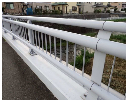
写真-5.8 修繕後（取り換え）
