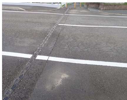
写真-5.6 修繕後（取り換え）
