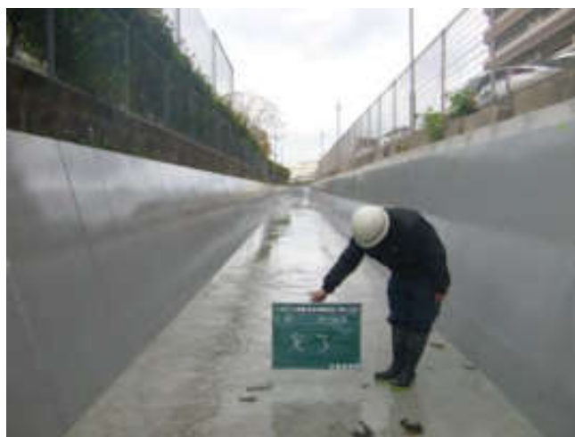
図 雨水幹線改良工事
