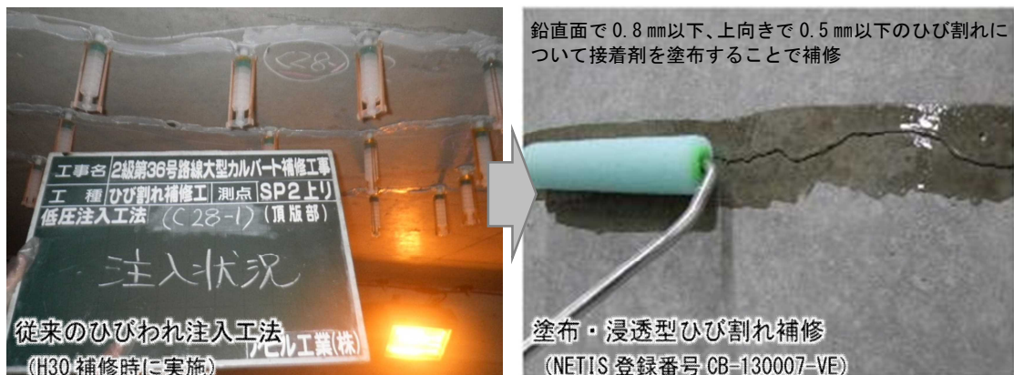
図-4 補修の新工法
