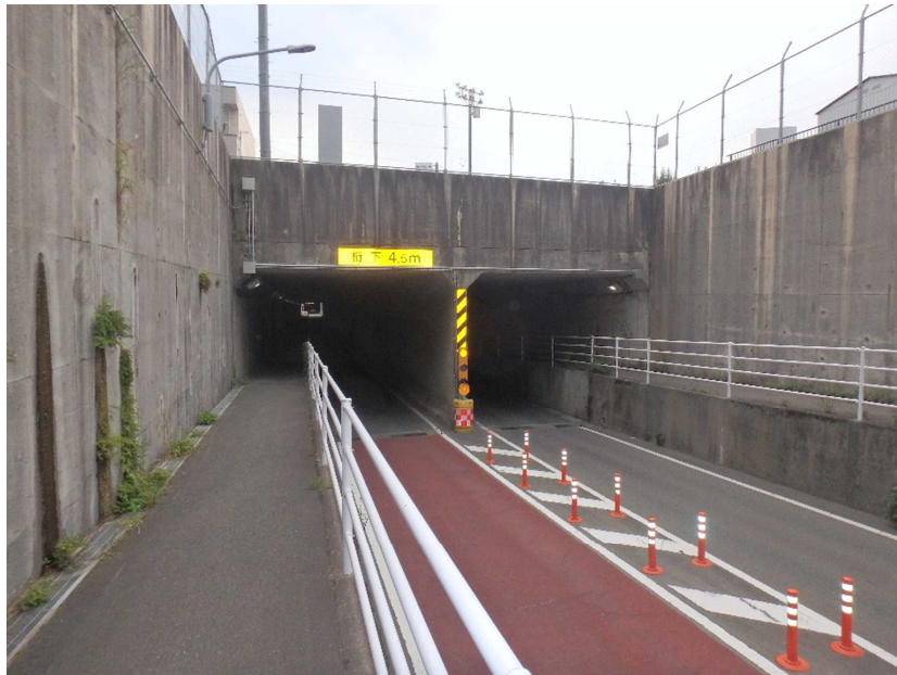
図-1 管理大型カルバート（2級第36号路線ボックスカルバート）
