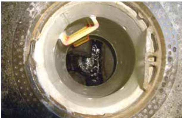
改築した汚水管路
