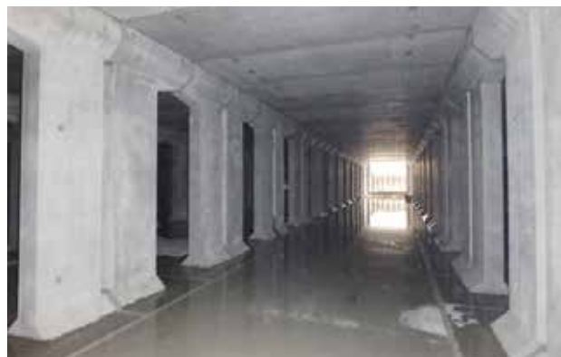
小倉第2雨水貯留施設内部
