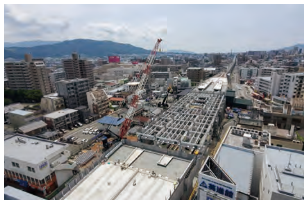
▲春日原駅舎建築工事の状況(令和3年6月末時点)
