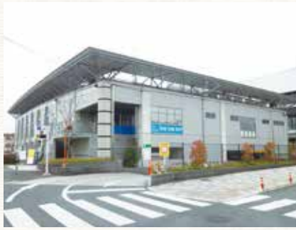
▲総合スポーツセンター温水プール
