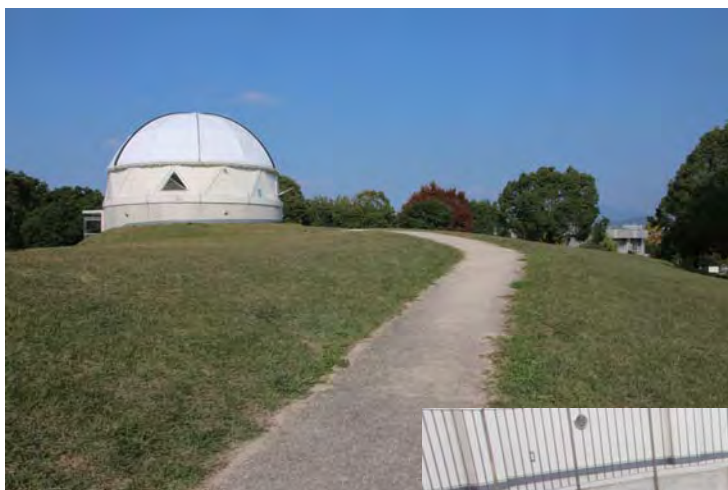
①地下遺構への負担軽減や可逆性に配慮した遺構露出展示施設（覆屋）
