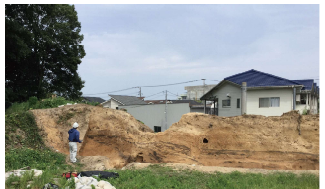
版築によって積み上げた土塁（天神山）
