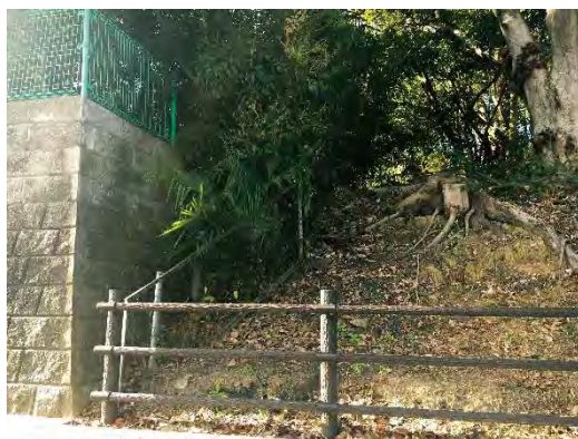
写真 3-41 ②⑧西側土塁 南側史跡境界の状況
