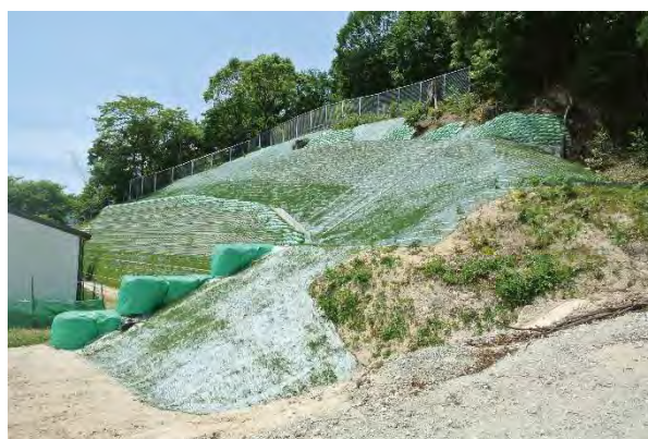
写真2－8 天神山水城跡災害復旧後の状況
