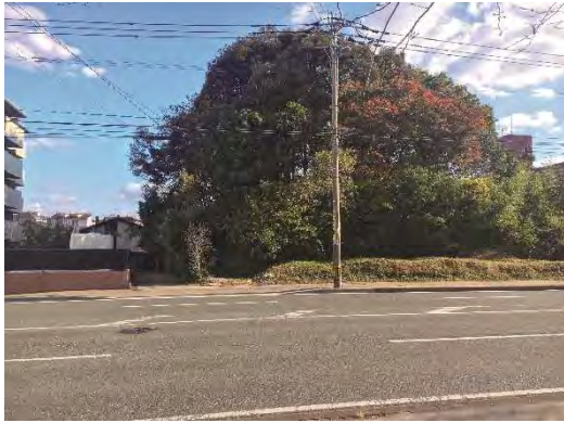
写真 3-14 ①東側土塁 県道沿いの外観
