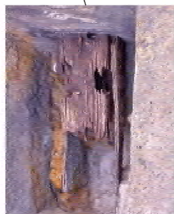
吐水部側に残る木樋
