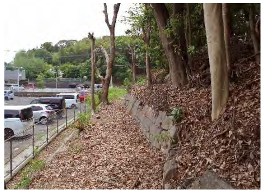
写真 3-27 ⑭東側土塁 宅地跡の石積み擁壁
