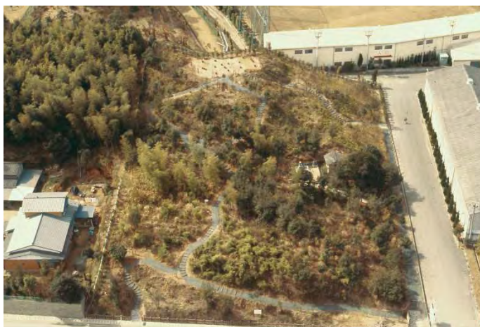
写真3-4 大土居水城跡自然丘陵部の環境整備 （昭和54年（1979）撮影）
