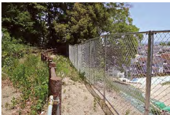
写真 3-68 ㉓丘陵部 東側フェンス
