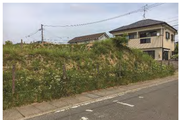
写真 3-53 ⑧西側土塁 土塁断面切通し状況
