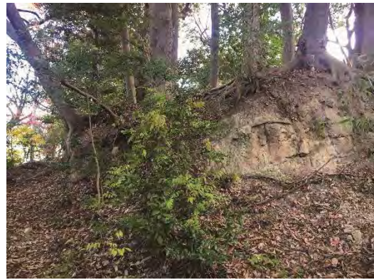
写真 3-19 ⑥東側土塁 階段状に掘削された土塁
