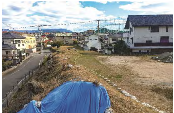
写真 3-59 ⑭西側土塁 東側土塁を望む
