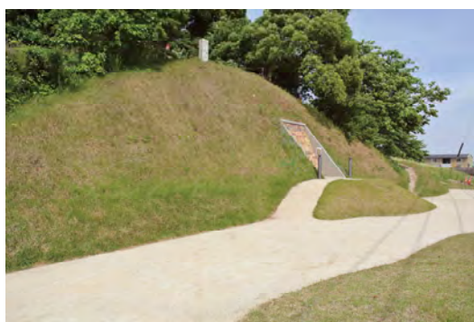
写真 5-8 土系舗装の広場・園路（土塁断面ひろば）
