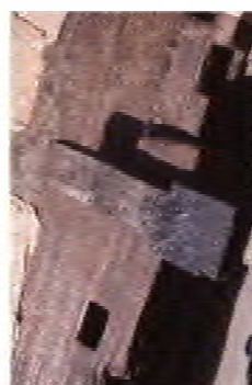
抜き取り後の大樋
