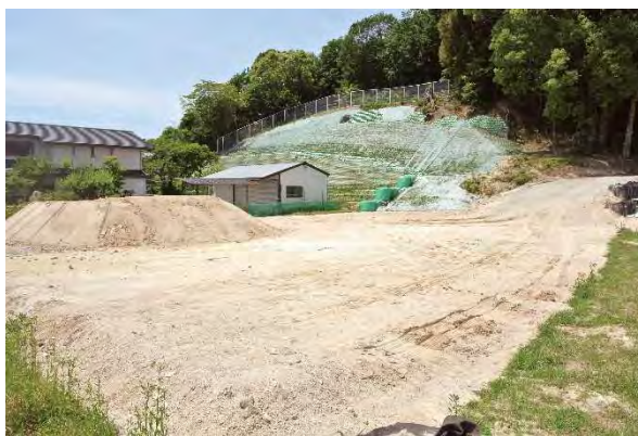
写真 3-13 天神山水城跡 丘陵東側災害復旧状況
