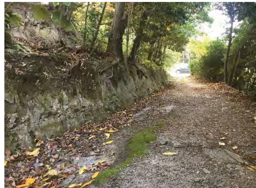
写真 3-17 ④東側土塁 階段状に掘削された土塁
