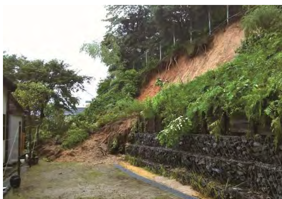
写真2－7 天神山水城跡崩落時の状況
