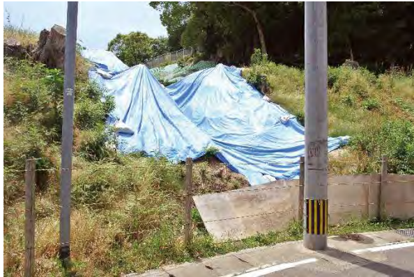
写真 3-56 ⑪西側土塁 発掘調査箇所の養生
