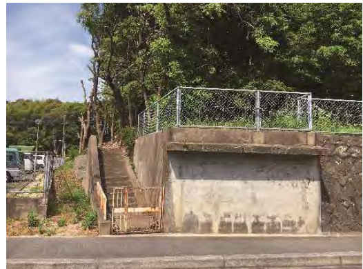
写真 3-23 ⑩東側土塁 擁壁等の工作物
