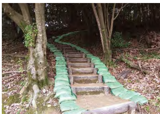
写真 3－6 大土居水城跡 園路階段の補修
