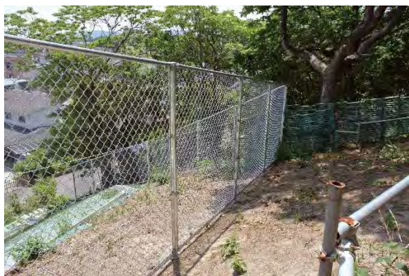
写真 3-12 天神山水城跡 災害危険箇所進入防止柵設置
