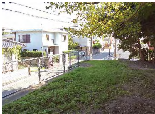
写真 3-31 ⑬東側土塁 土塁東端部の状況
