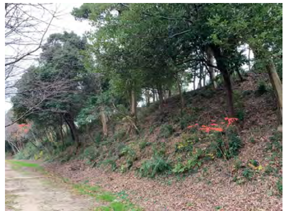
写真５－１ 樹林調整により土塁天端の形状を見せている（大水城北側）
