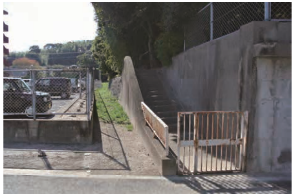
写真6 東端部のコンクリート工作物
