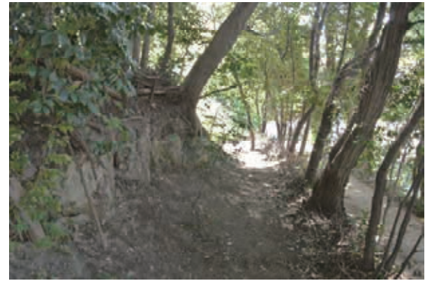
写真 20 旧宅地進入路により段差の生じた土塁
