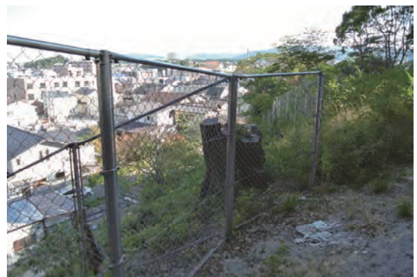
写真22 自然丘陵頂部（危険箇所のフェンス）
