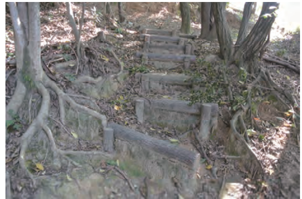
写真 38 整備された階段の状況
