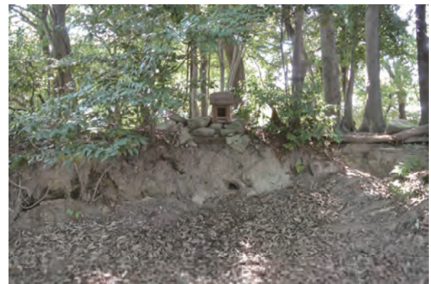
写真16 旧宅地により段差が生じた土塁
