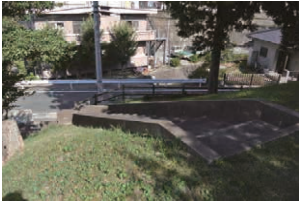
写真9 東端部 コンクリートの階段
