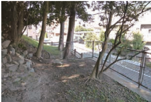
写真11 宅地跡のコンクリート工作物
