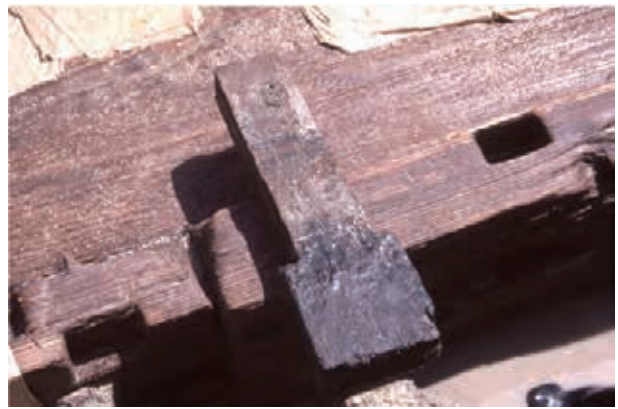
抜き取り後の大栓 (2次調査)
