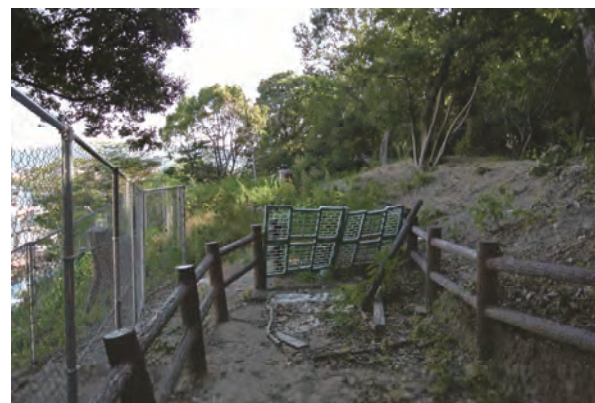
写真21 自然丘陵頂部（危険箇所のフェンス）
