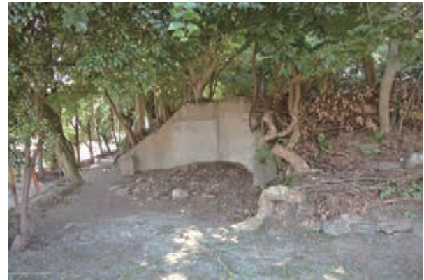
写真12 宅地跡のコンクリート工作物
