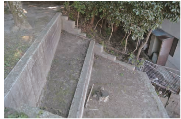
写真 22 土塁北側のコンクリート擁壁
