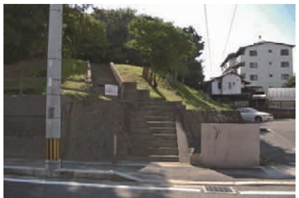
写真8 東端部 コンクリートの階段
