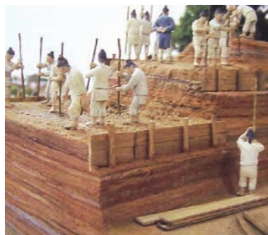
水城版築工事のようす(模型)
