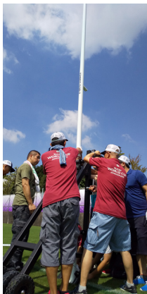
ゴールポールの設置作業
