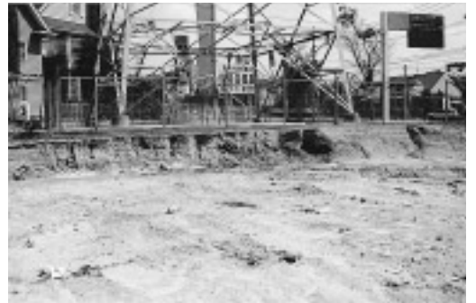
工事が中断している交番建設予定地（惣利）
