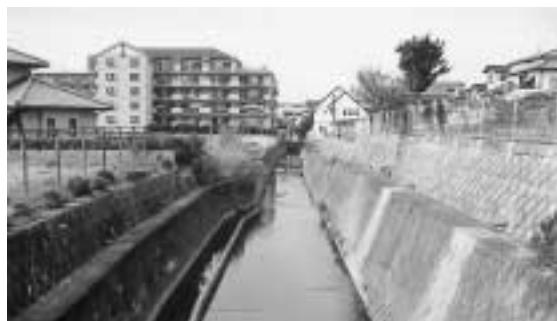
小倉第1雨水幹線 (昇町7丁目付近)
