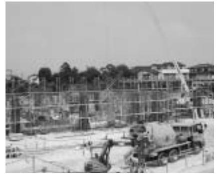
建設が進む白水小学校
