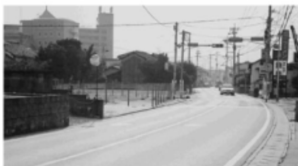
拡幅予定の県道那珂川字美線
