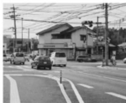
光町大土居線(拡幅された大土居交差点)
