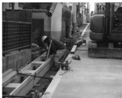
紅葉ヶ丘東の側溝整備
