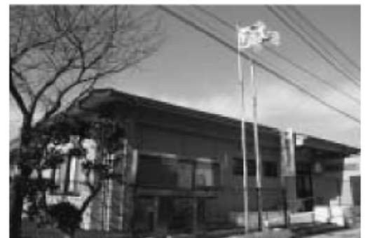
新築された塚原台公民館
