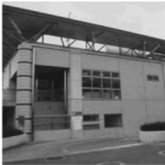
スポーツセンター温水プール
