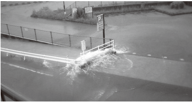
集中豪雨による浸水被害
