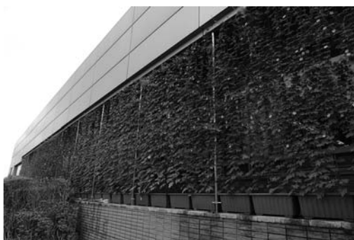
市役所の壁面緑化
