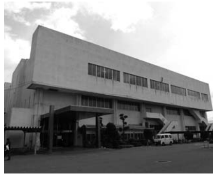
春日市立市民スポーツセンター
