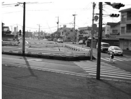
工事中的下白水工区
