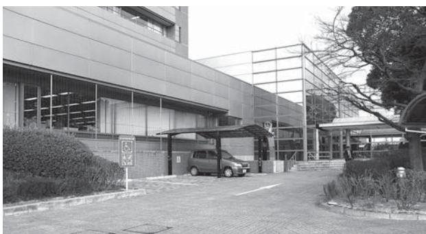
障がい者駐車場と多目的駐車区画
