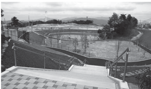
開発地内の調整池
