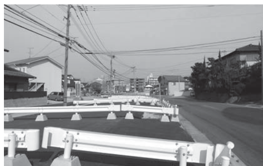
工事中の那珂川宇美線小倉工区
