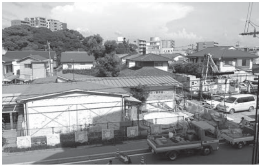
建て替え工事中の春日原保育所
