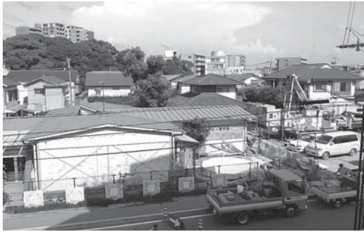
建て替え工事中の春日原保育所
