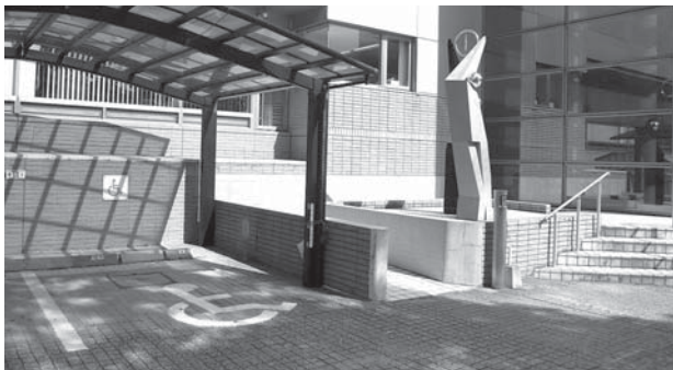
市庁舎玄関スロープと多目的駐車場
