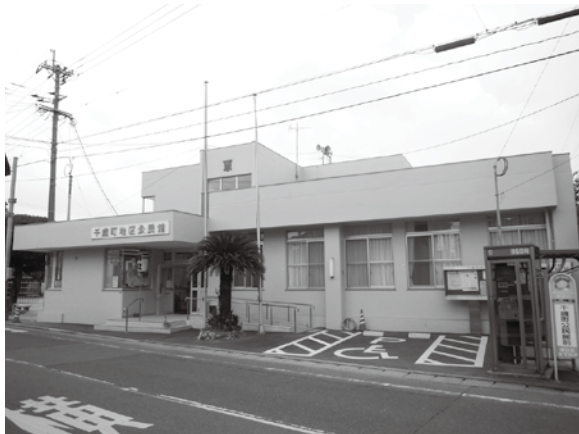
改修後の千歳町公民館
