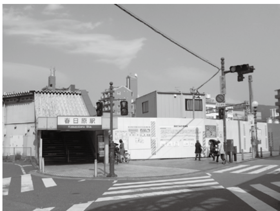
連続立体交差事業の進捗
