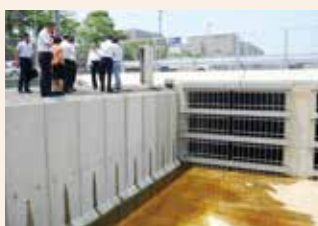
小倉第2雨水貯留施設
