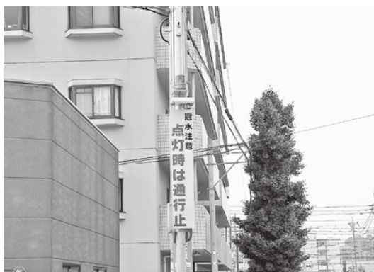
パトライトと呼ばれる道路冠水表示システム
