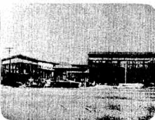
児童館建築工事
