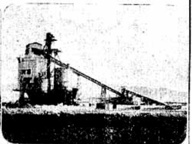
麻生コンクリート工場
