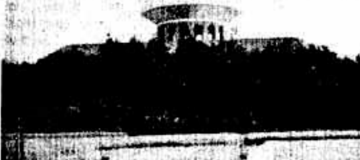
観光道路よりみた天神山配水塔
