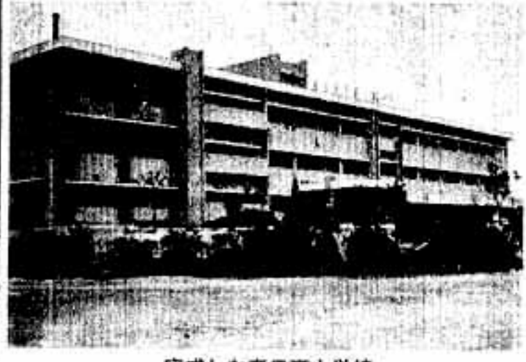
完成した春日東小学校
