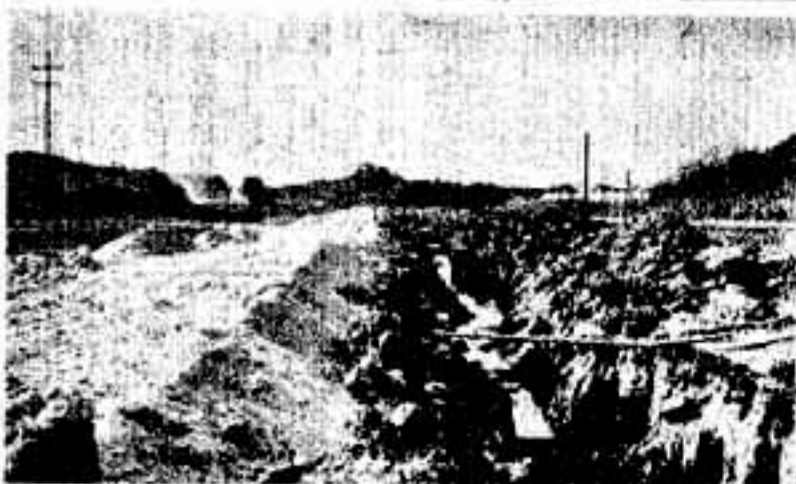
昇町土地改良工事現場
